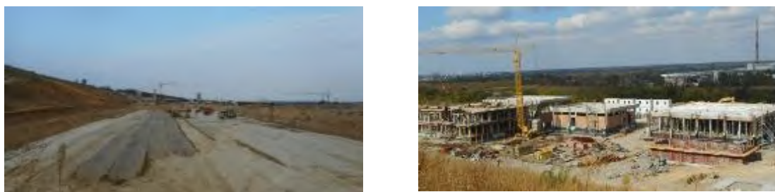
Figura 2: Costruzione dell'impianto di smaltimento nazionale foto SERAW
